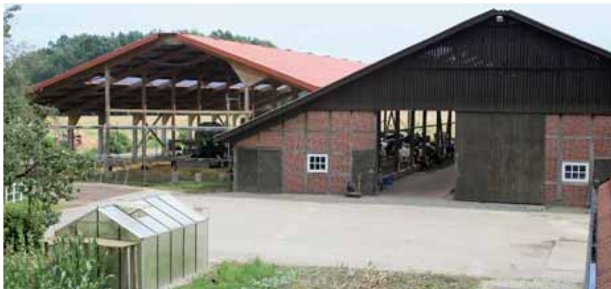
Ende 2005 begannen Alfons Teipen-Backsmann und seine Frau Irmgard Backsmann mit dem Neu- und Umbau des Milchviehstalls.
